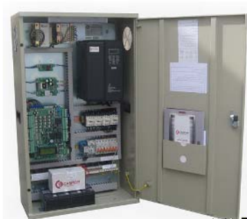
شکل ۶-۷- نمونه‌ای از تابلو کنترل و فرمان
