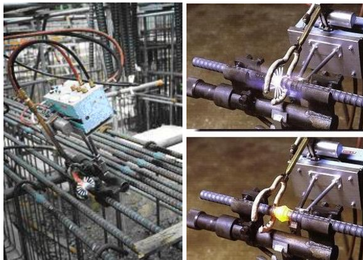
شکل ۱-۱۶: دستگاه جوشکاری فشاری اتوماتیک (Kanatsu Co. Ltd, Japan)
