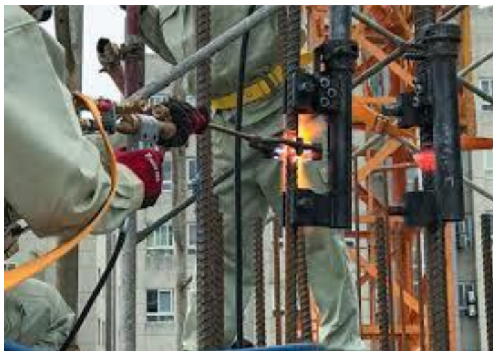
شکل ۱-۱۵: جوشکاری فشاری گازی دستی
