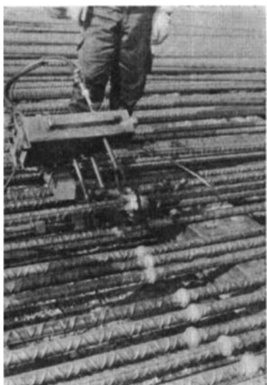
شکل ۳-۸: دستگاه جوش اتوماتیک در حال انجام جوش میلگردهای قائم و افقی سازه بتن‌آرمه (Takano et al. , 1977)
