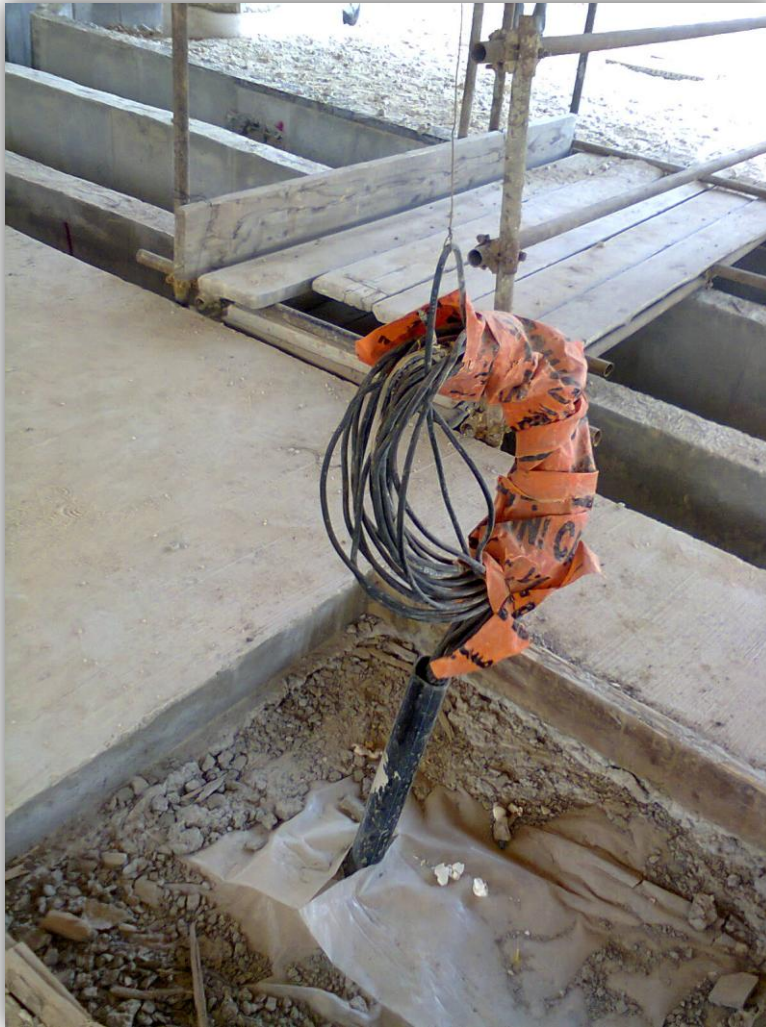
شکل ۷-۲- سرکابل آیندهای کابلی که به کانتکتور وصل می شود
