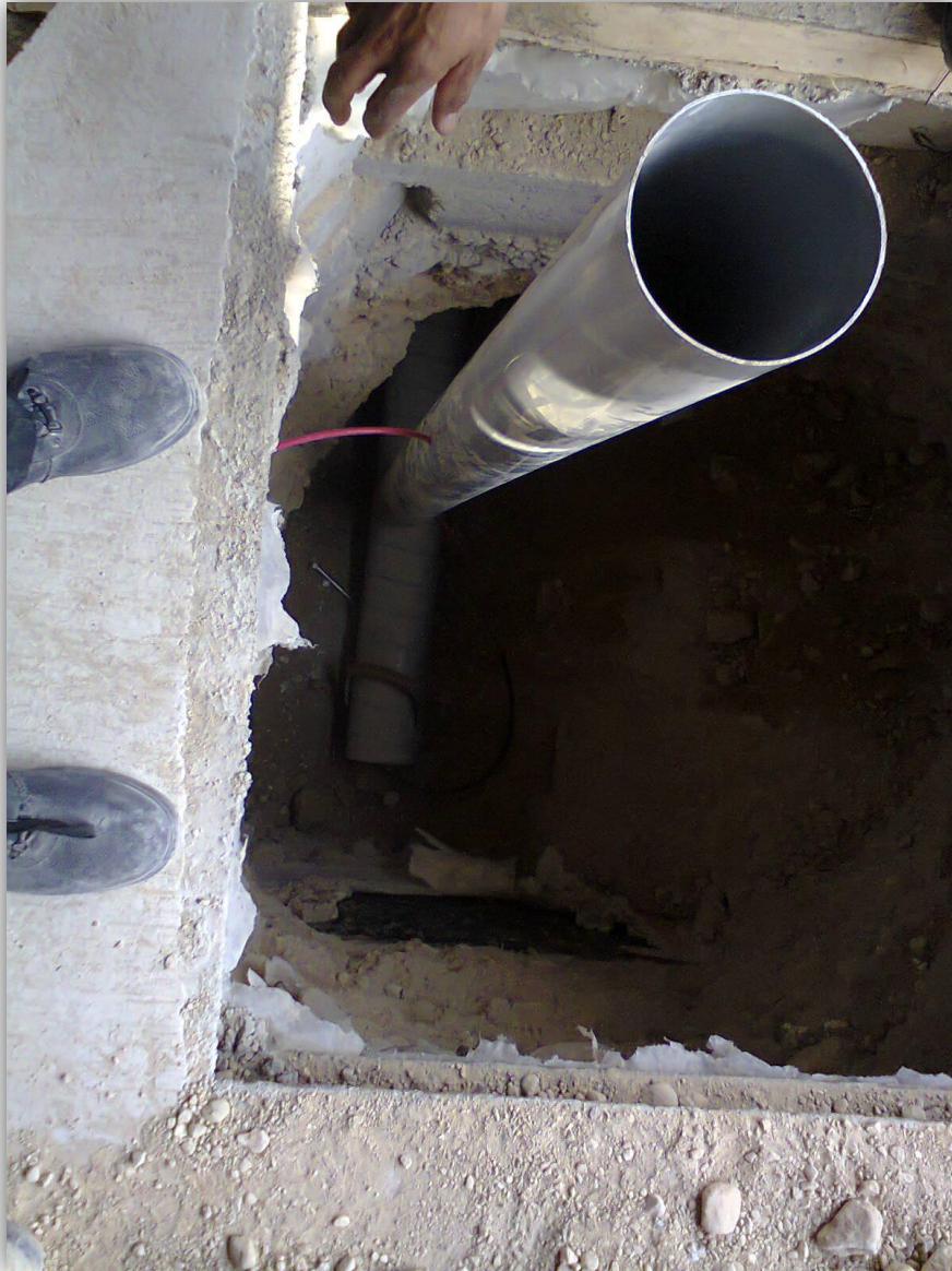
شکل ۷-۱۴- داخل این لوله پلیکا آند تیوب لار قرار می دهند اطراف آن را با سنگ پر می کنند تا گازی که اطراف آند است به بالا بیاید.
