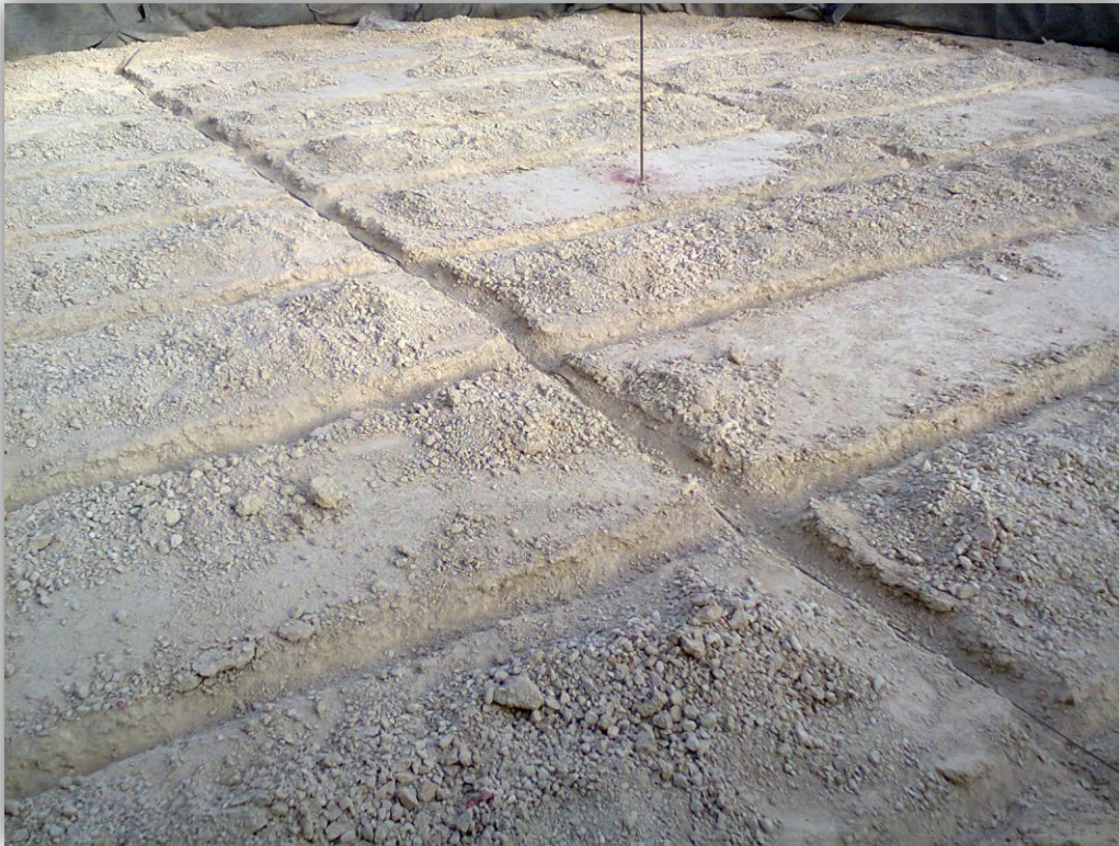
شکل ۷-۵- شبکه بندی جهت کنترل خوردگی و حفاظت از کلیه ادوات ورق های آندی تیتانیوم با جریان برق وصل می شود و بعد به کانتکتور وصل می نمایم.
