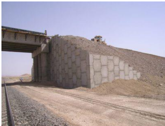
نمونه ای از یک دیوار حائل در راه آهن
