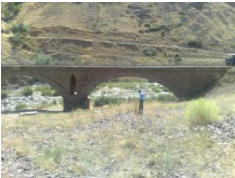
نمونه ای از پل طاقی چند دهانه خوابیده در ناحیه شمالغرب
