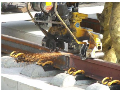
تراش ریل پس از عملیات جوش درز ریل
