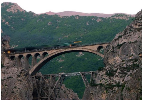
پل ورسک با طول ۸۶ متر و ارتفاع ۱۱۰ متر واقع در راه آهن ناحیه شما ساخته شده در سال ۱۳۱۵
