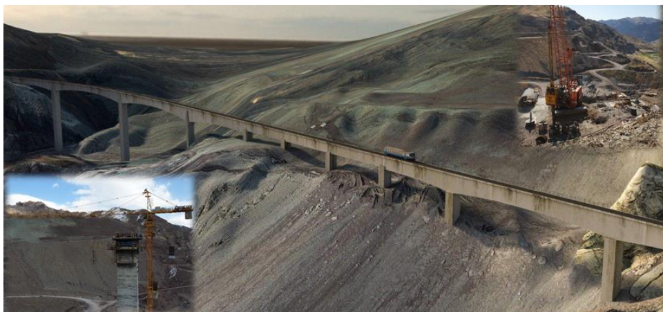
پل بزرگ سارای واقع در راه آهن میانه - اردبیل اجرا شده با قالب های ایرانی توسط
