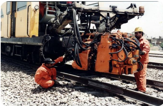
جوشکاری درز ریل به وسیله ماشین جوش الکتریک
