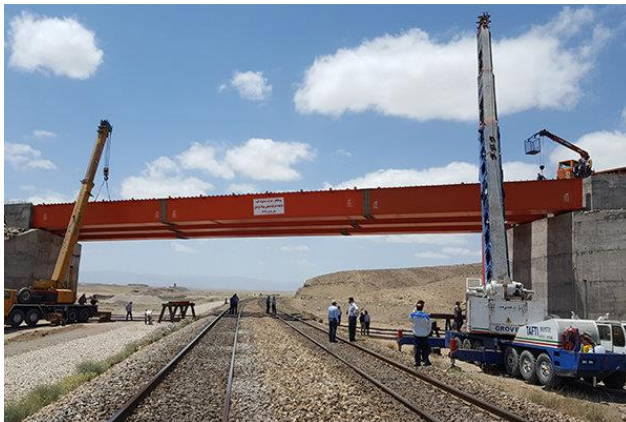
نمونه ای از روگذر راه آهن (در حال احداث)
