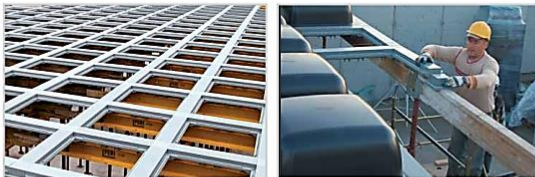
شکل ۸. قالب بندی و کفراژ بندی
