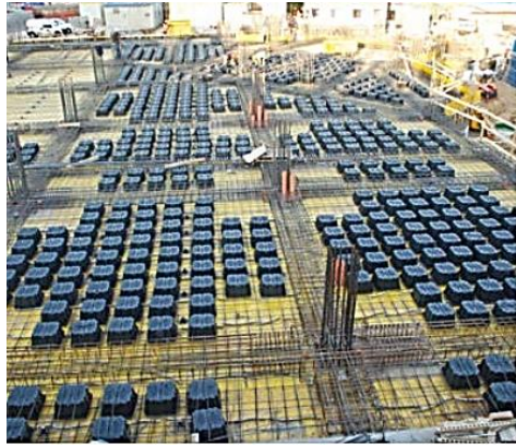
شکل ۳. نمونه ای از مقطع و اجرای دال حبابی (قالب ماندگار موسوم به یوبوت)
