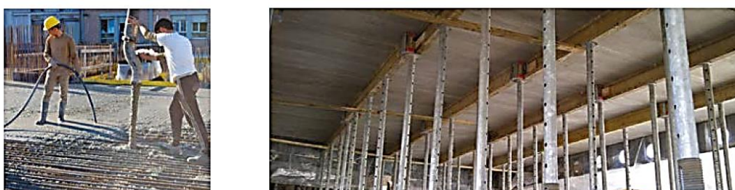
شکل ۱۷ مراحل انتهایی اجرای سقف یوبوت
