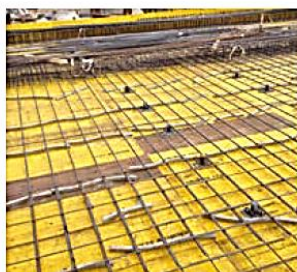
شکل ۱۵. مراحل الف تا ج اجرای دال یوبوت
