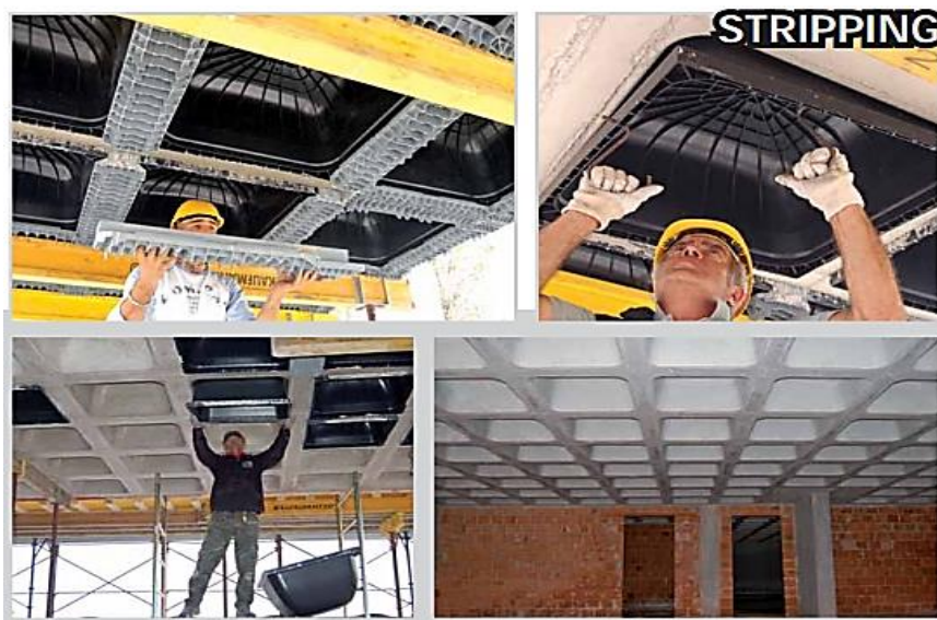
شکل ۱۲. بازکردن قالب ها
