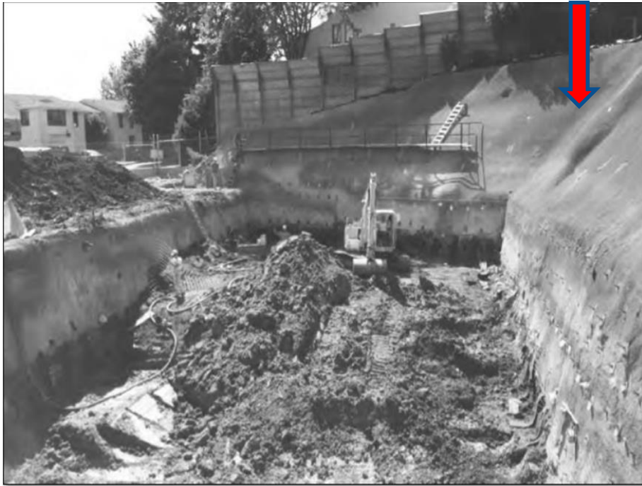
محافظت از شیب با اجرای لایه شاکریت
