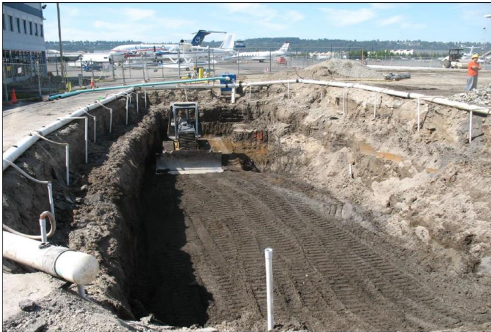
استفاده از چاهک‌های نقطه‌ای در خشک‌سازی یک محدوده گودبرداری
