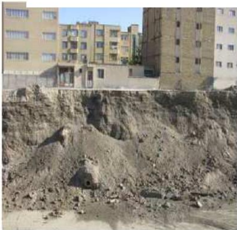
(ب) ریزش دیواره و ایجاد ترک در ساختمان
