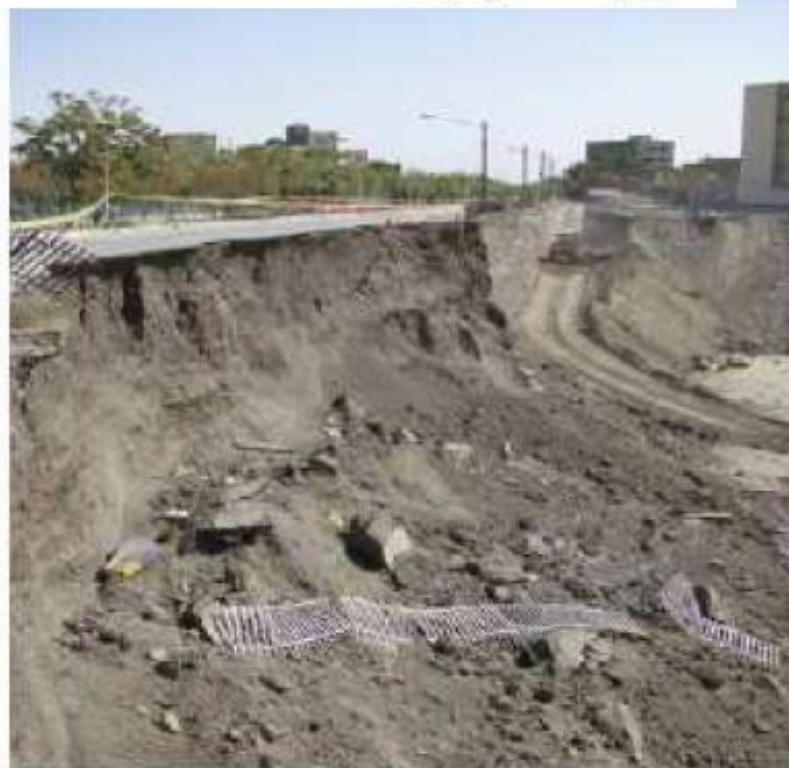
(الف) ریزش دیواره و خسارت به خیابان مجاور
