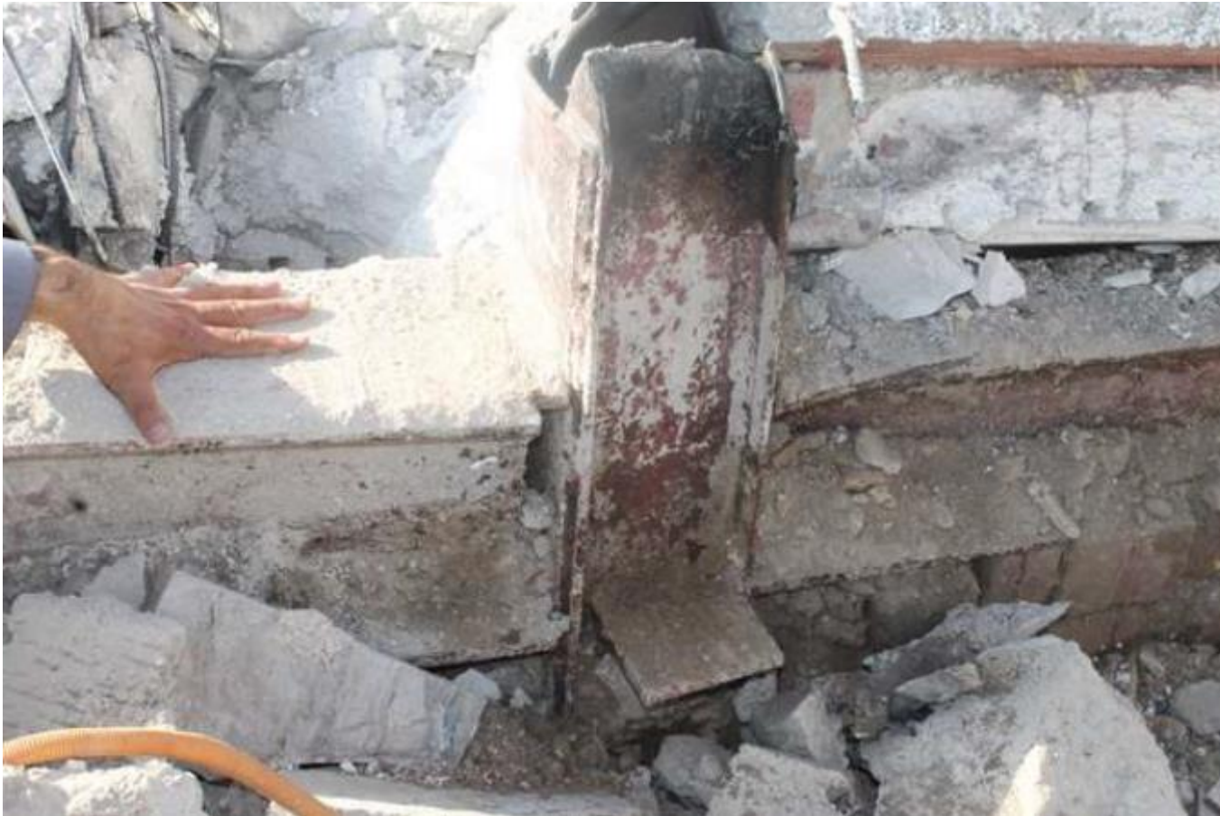
عدم رعایت ضابطه تیر ضعیف - ستون قوی
