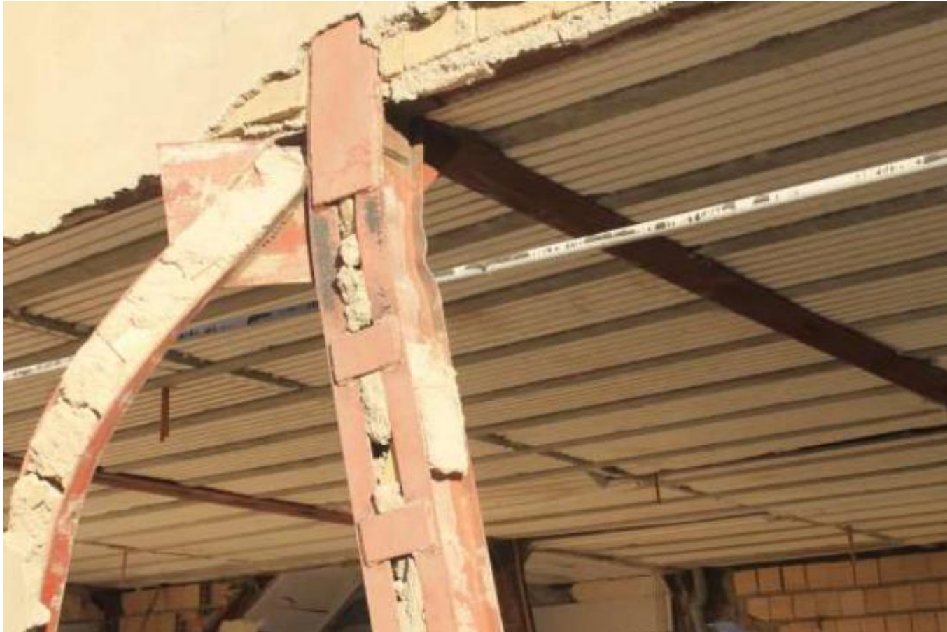
کمانش ستون دارای بست افقی (پا باز)
