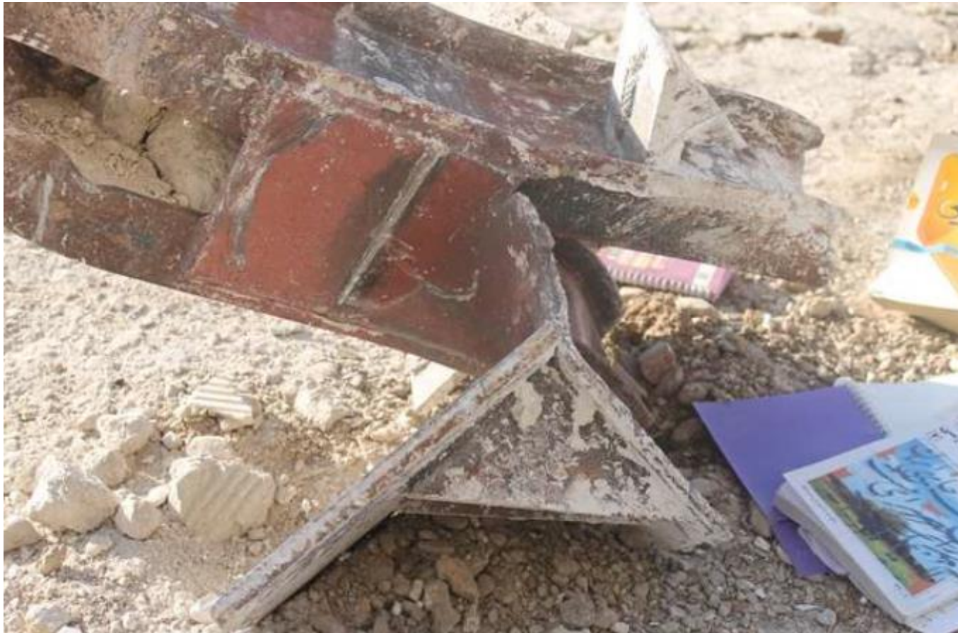
پارگی صفحه اتصال به ستون دارای بست افقی
