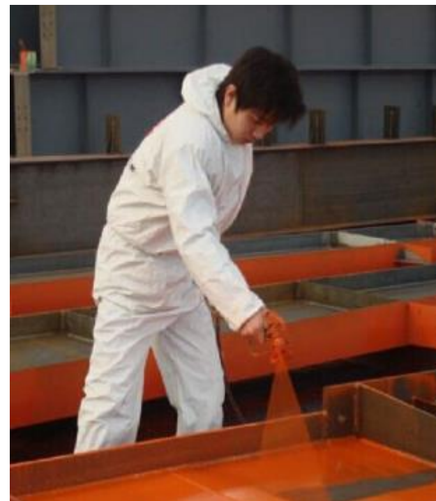
اجرای عملیات رنگ آمیزی
