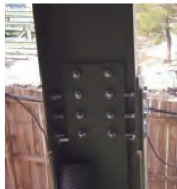
اتصال ستون به ستون بصورت پیچ و مهره‌ای
