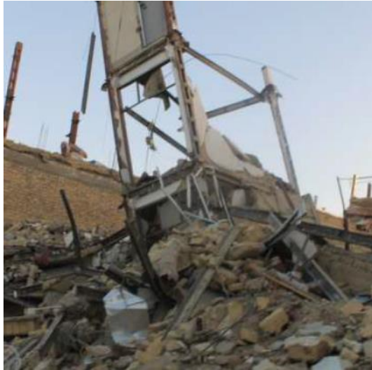
فروریزش ساختمان فولادی در سرپل ذهاب
