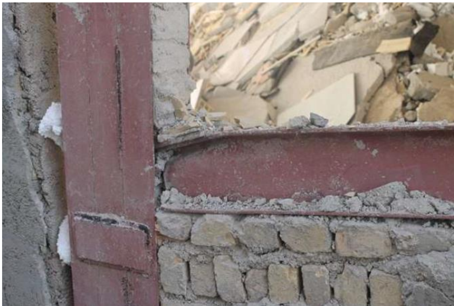
کمانش جان تیر در محل اتصال به ستون
