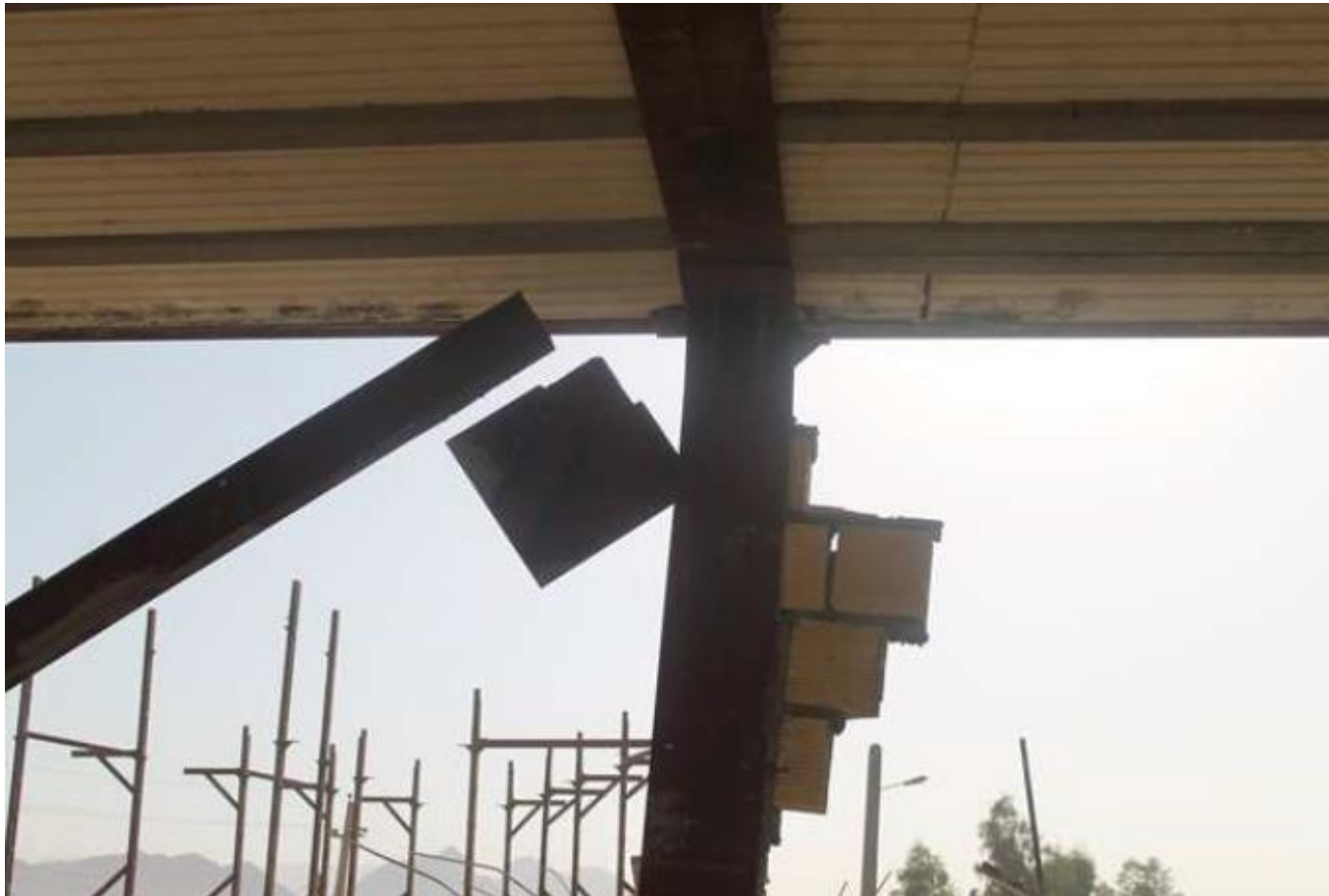
کنده شدن اتصالات صفحه اتصال و ستون و همچنین مهاربند و صفحه اتصال
