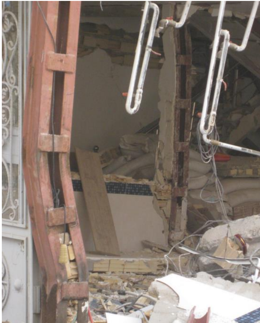
ضعف ستون دارای بست افقی (پا باز) در مقابل کمانش
