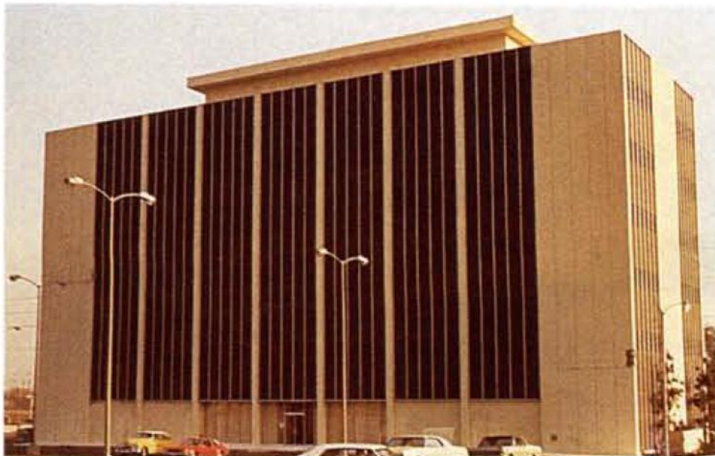
شکل ۲-۳۶- ساختمان ایندین هیلز، زلزله‌ی نورتریج
