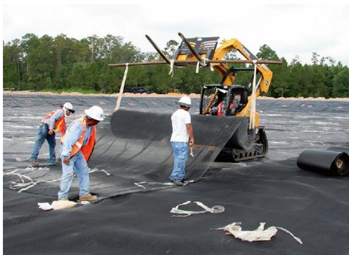
شکل ۴-۳ نصب لایه محافظ (ژئوتکستایل) در کف لندفیل [۲۱]
