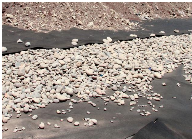
شکل ۳-۳ لایه های زهکش معدنی در کف لندفیل [۲۱]
