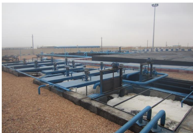
شکل ۳-۵ سیستم جمع آوری شیرابه تولید شده در محل دفن بهداشتی[۲۱]
