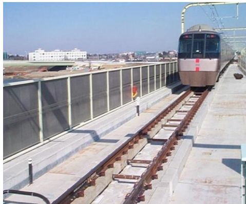
شکل ۲-۲۵: نمونه‌ای از اجرای روسازی نردبانی شناور اجراشده بر روی بستر بتنی L شکل [۳۸].
