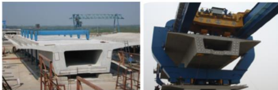
آ. پیش‌ساخته و نصب
