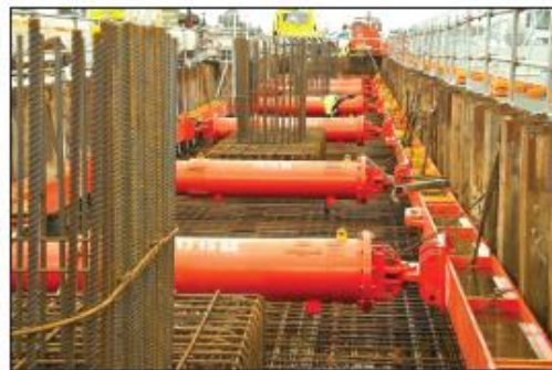
شکل ۱- روش مهاربندی متقابل
