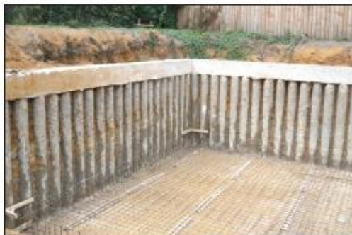
شکل ۴- روش مهار بندی توسط شمع های درجا
