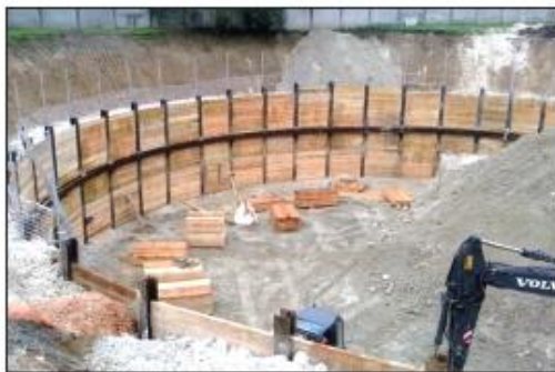
شکل ۲- روش مهاربندی توسط امان‌های کششی
