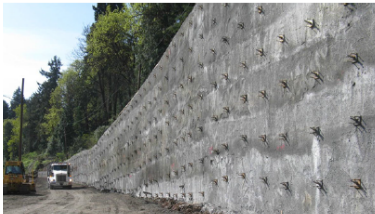
شکل ۱- نمایی از یک گود پایدار شده به روش نیلینگ
