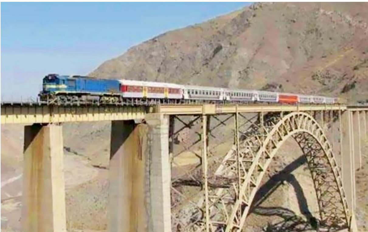
شکل ۲-۹- پل قوسی فلزی قطور خوی در آذربایجان غربی به طول ۴۴۸ متر قرار گرفته بر روی پایه های بتنی
