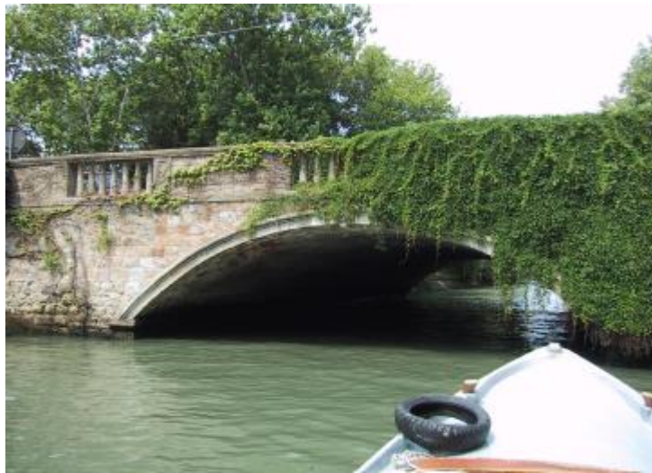
شکل ۲-۴۵- نمایی از پل سندرو گالو در شهر ونیز ایتالیا [۲۴]
