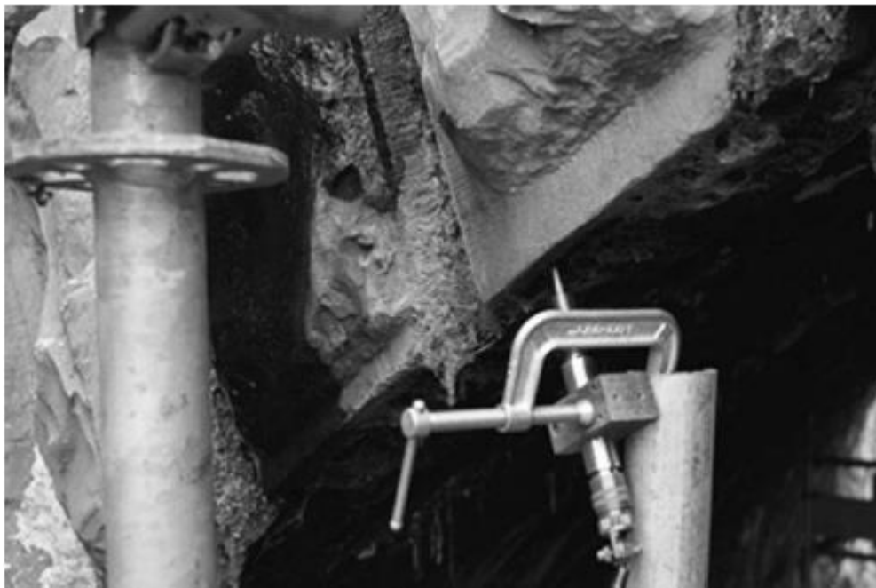
شکل ۲-۵۸- نصب نمونه ای از وسایل اندازه گیری در سطح پل قوسی گرفتیت [۲۳]
