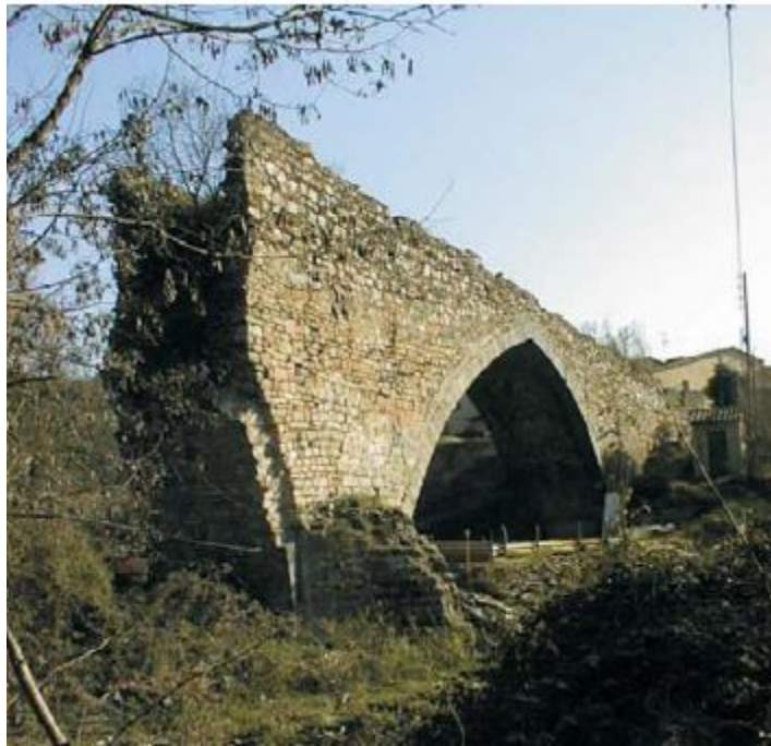
شکل ۲-۳- نمایی از پل موسوم به پل شکسته قبل از انجام عملیات مرمت [۱۰]
