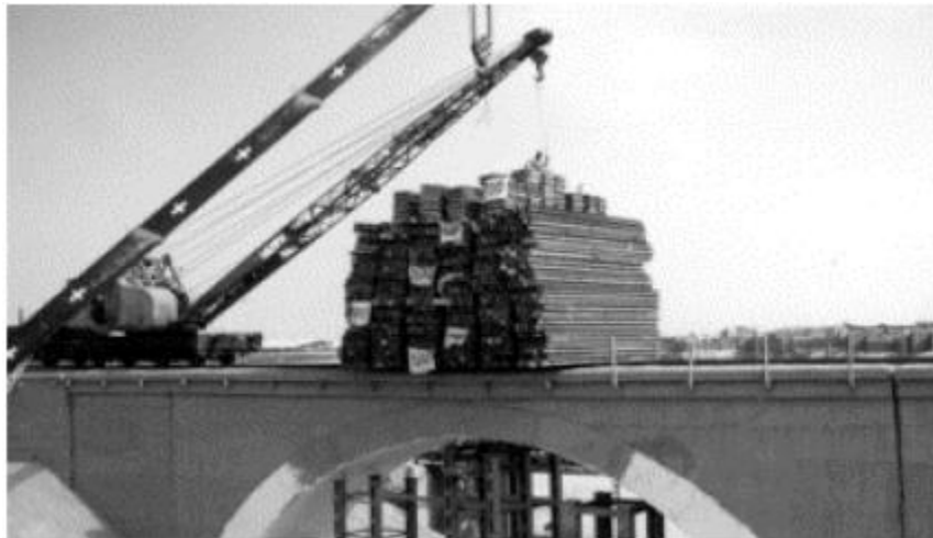
شکل ۲-۵۰- نحوه انجام بارگذاری بر روی یکی از دهانه های پل کیلومتر ۲۳ [۲۹]
