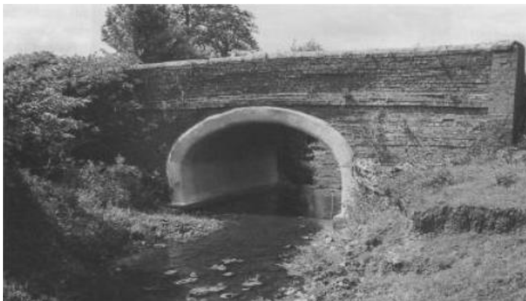
شکل ۳-۴- قوس بتنی کل وجه بیرونی قوس و پایه‌های آن را پوشانده است [۴۴]
