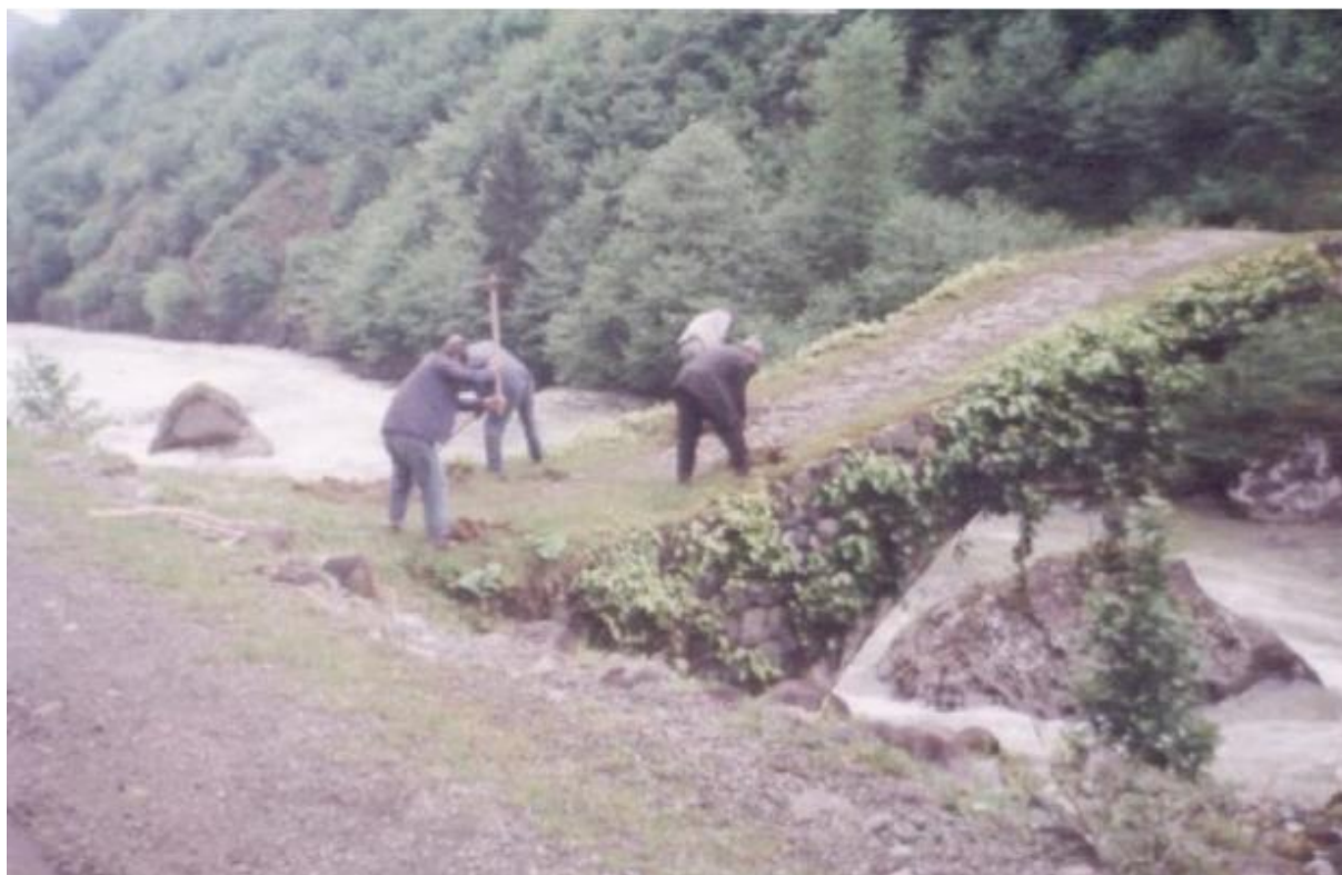
شکل ۲-۳۵- تمیز کردن پل از پوشش گیاهی ایجاد شده در سطح آن- پل اورانکیت ترکیه [۲۶]
