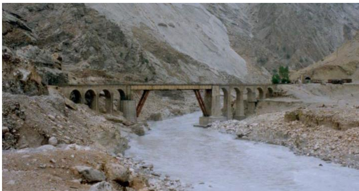
شکل ۱-۷- پل تله زنگ پس از بازسازی و مرمت (سال ۱۳۷۹) [۵۰]
