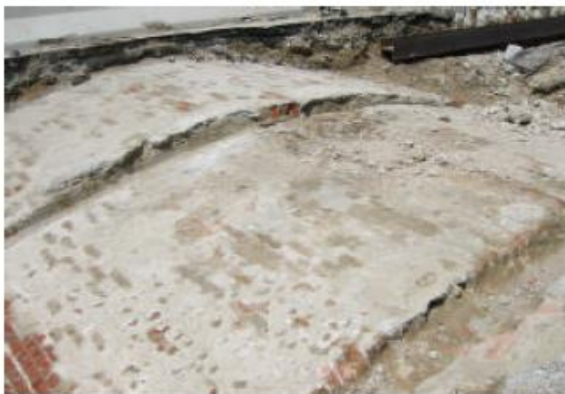
شکل ۲-۴۶- پل قوسی سنگی پس از خارج کردن خاکریز روی پل [۲۴]
