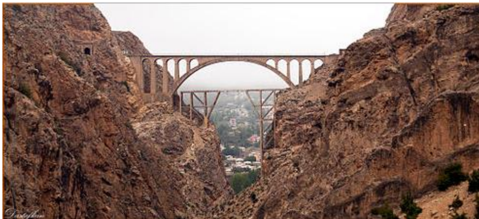
شکل ۲-۸- پل راه آهن ورسک به طول دهانه ۶۶ متر ساخته شده از مصالح بنایی سنتی چون سیمان و آجر
