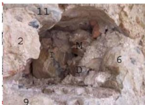
شکل ۴-۱- نمونه‌ای از سوراخ ایجاد شده در قسمتی از پل سنگی [۴۲]
