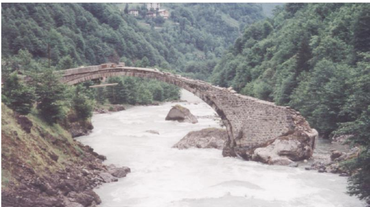
شکل ۲-۲۹- شکست ایجاد شده در پل "اورانکیت" در اثر سیل [۲۶]
