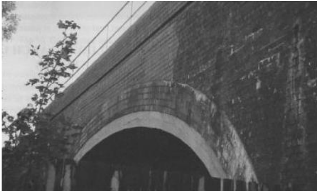
شکل ۴-۴- قوس بتنی فقط قسمت نمای تحتانی قوس سنگی را پوشانده است.
